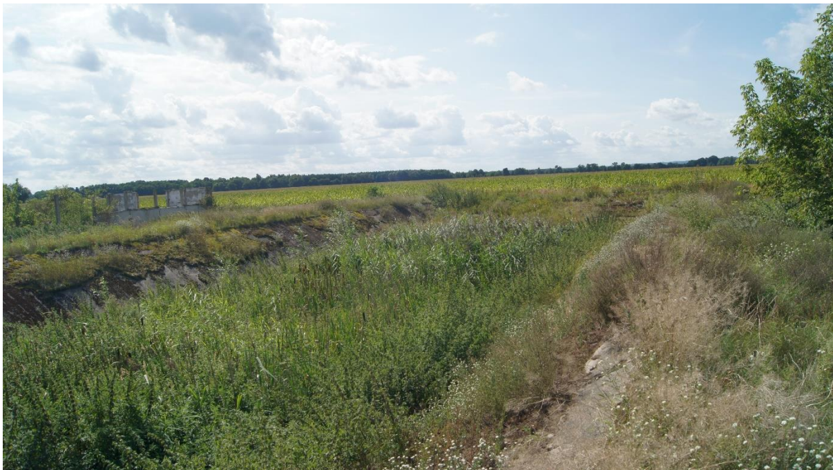
Abb. 4: Güllebecken mit Schilf - Brennesselflor vom Osten
